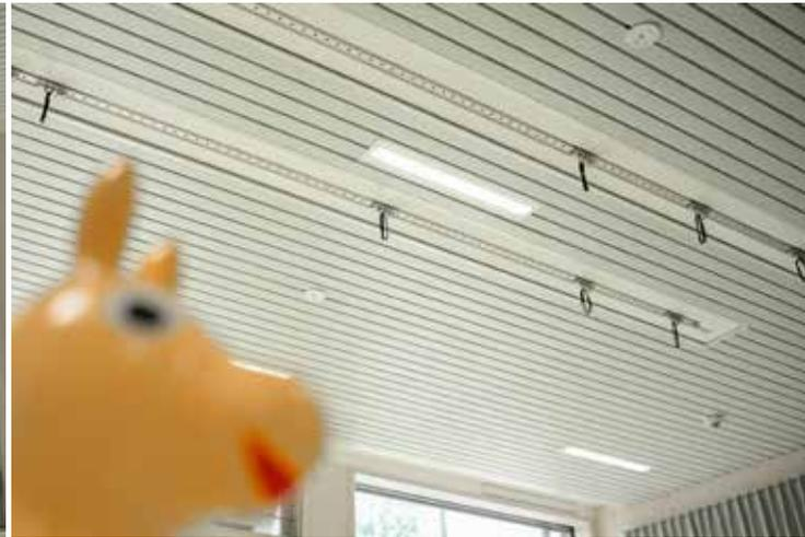
integrierte Beleuchtung gewährleistet eine gleichmäßige Ausleuchtung der Räume und trägt zur Energieeffizienz des Gebäudes bei. Haben alle Personen einen Raum verlassen, schaltet sich das Deckenlicht automatisch ab.
